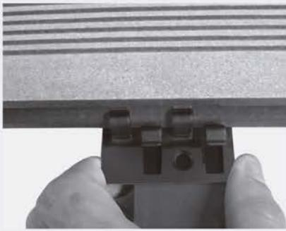
**ES.** Coloque el borde de la fijación sobre el lateral del rastrel, así el tornillo quedará centrado con respecto a éste.
